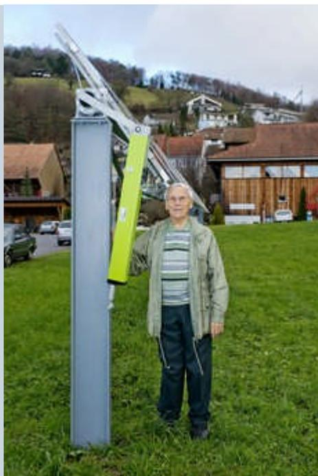
An der Demonstrationsanlage in Endingen zeigt Emil Bächli die seitliche Verankerung und Steuerung der Solarmodule.
